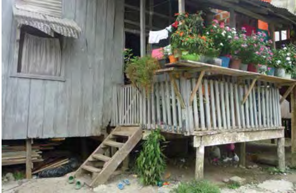
Casa del antiguo campamento de los gringos de la Chocó Pacífico en Andagoya. Foto: Jairo Barbosa.
